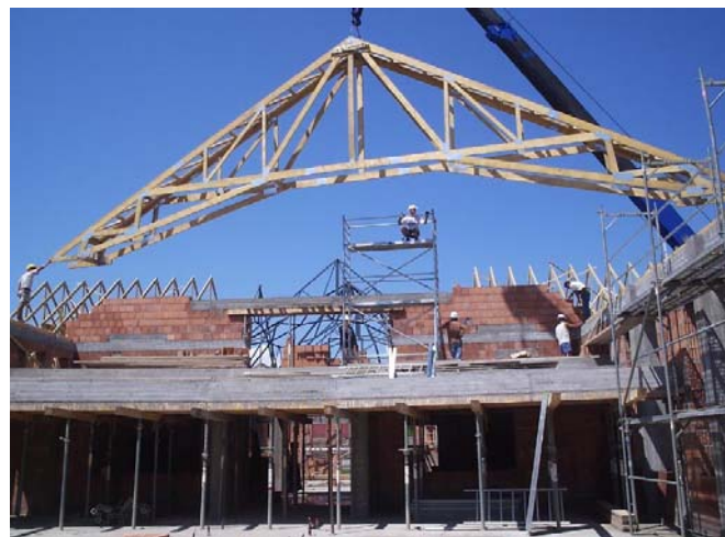
13.ábra Templomtető ollós szeglemezes tartói, a szerkezet beemelése a karzat fölé
