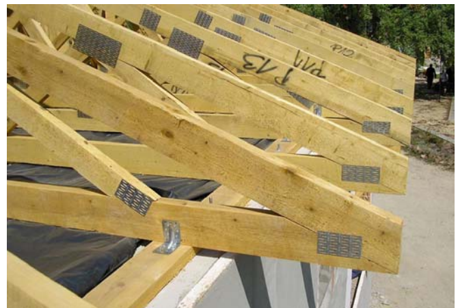
27. ábra Kis fesztávú szerkezet (családi ház) felfekvése
