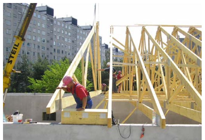
50. ábra Tetőrácshoz tartozó főállás beemelése
