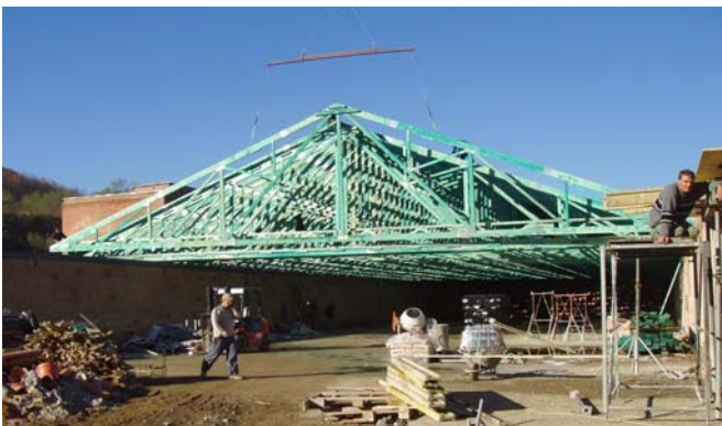
46. ábra Rácsostartó beemelése gerendahimbával
