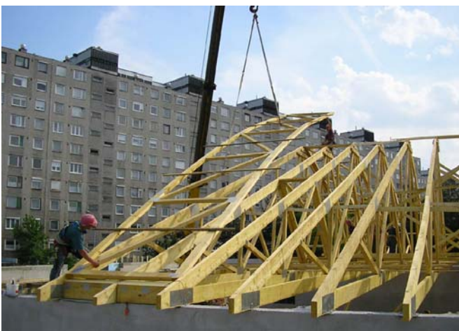
52. ábra Az előregyártott tetőrács beemelése
