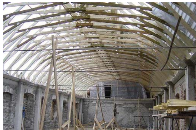
14.ábra Műemlék kastély kikönyökölt Studio-fedélszéke, vonórudakkal
