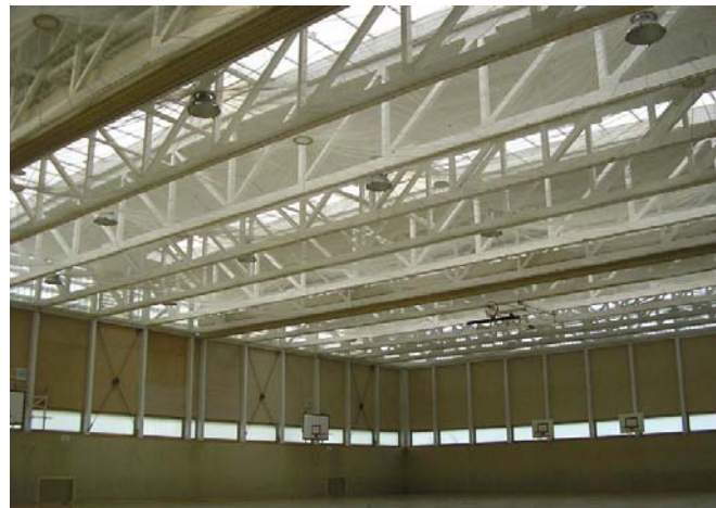
12.a-b ábrák Tornacsarnok és tetőszerkezete látszó szeglemezes rácsostartók
