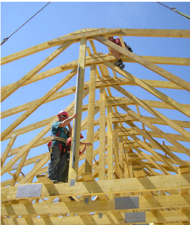
47. ábra Tartószerkezet függőzése, darumegfogással
