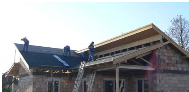
5. ábra Szeglemez-es félnyeregtes-tetőszerkezet fedése
