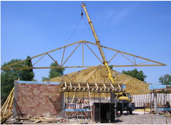
45. ábra Rácsostartó beemelése kötélhimbával
