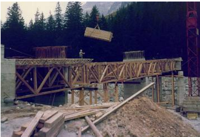
21. ábra Autópályahíd zsaluzatának szeglemezes tartói, Greim-rendszerrel, H. Banholzer AG, Svájc
