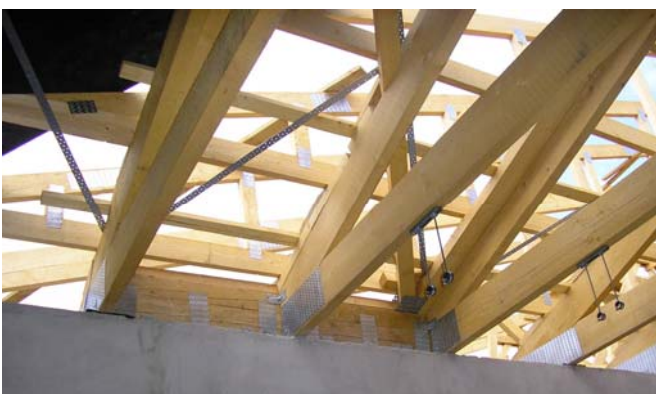
53. ábra Szegszalag tetőmerevítések
