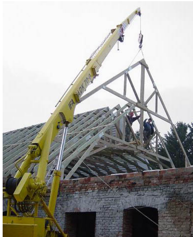
1. ábra Szeglemez-es tartó beemelése műemlék épület falaira
