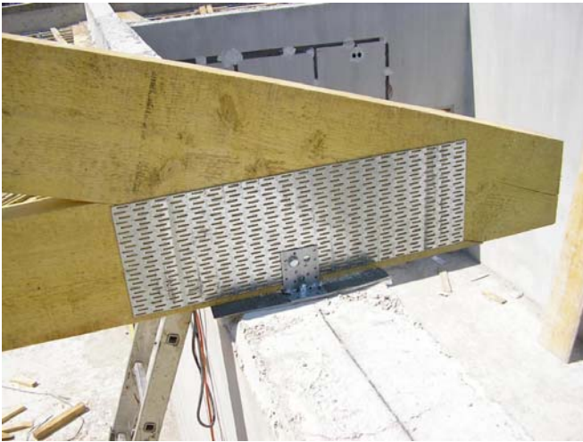
28. ábra Nagy fesztávú szerkezet (csarnok) támasza
