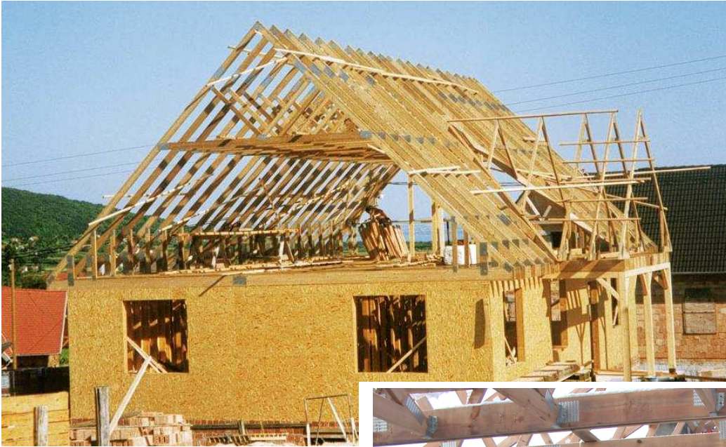
Fafödémrel egybeépített tetőszerkezet
