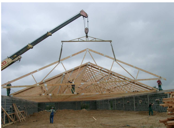
MiTek tetőszerkezet építése
